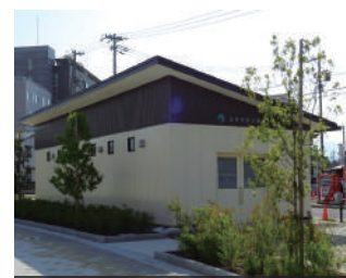
長野駅東口公園防災備蓄倉庫
