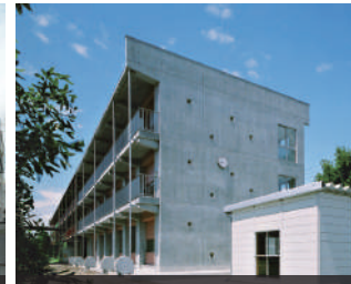
長野市立下氷鉦小学校北校舎
